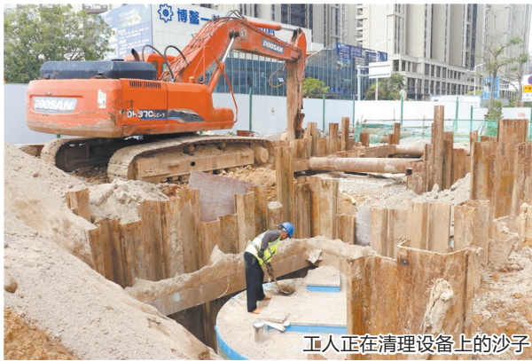
改造工程正在有序进行
