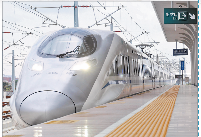
8月31日,福厦高铁运行试验列车驶入泉州南站。(陆逸 摄)
