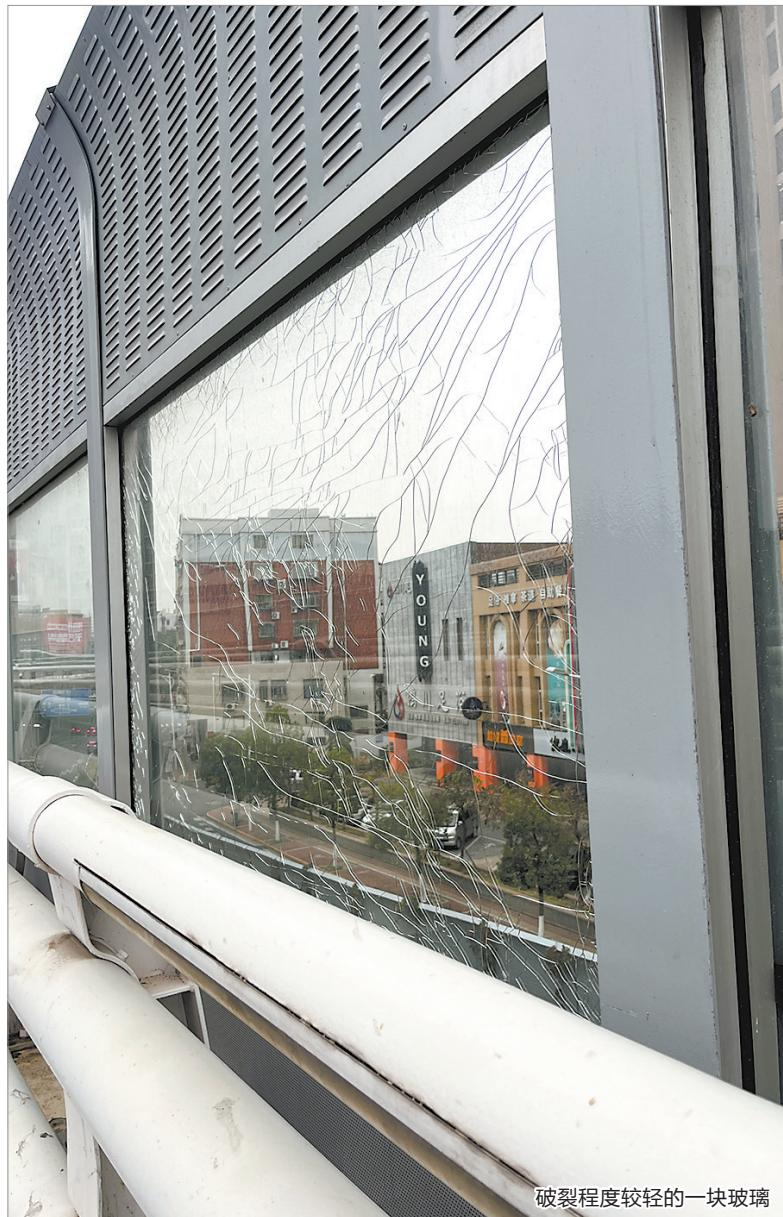
改善周边居住环境,提升居民的生活质量,泉州市城管局市政工程中心从2022年12月开始,在原有消声设施的基础上,对田安大桥(江滨北路至泉秀街段)北引桥及两个调头匝道和两个上下桥匝道加装隔音屏。该工程于2023年2月底基本完工。加装隔音屏总长度约2.3公里,隔音屏总体呈蓝灰色,上下使用隔音板,中央是透光的双层夹胶玻璃。
