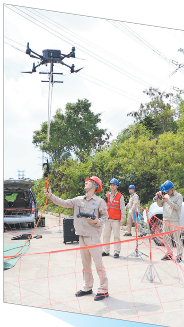
▲金黄色绝缘绳通过无人机精准地挂在架空地线上
