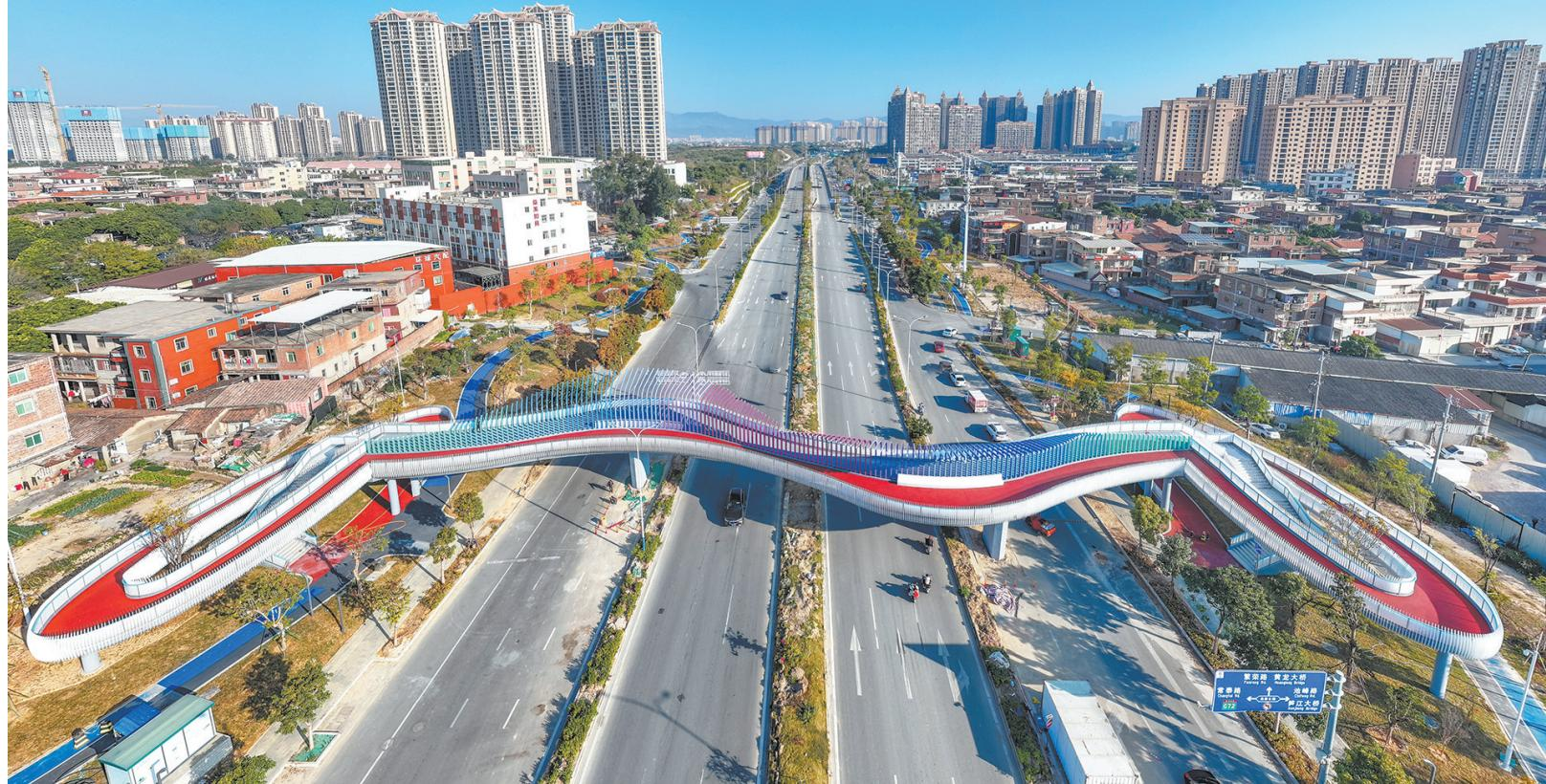
近日,中环城贯通工程首个节点天桥——黄龙南大道快捷化改造工程4号天桥完工。该天桥位于鲤城区泉南公路以南,南环路以北,横跨黄龙南大道。主桥长86米,宽5.5至9.6米。项目以“听风”为题,采用“多跨连续钢梁+景观栏杆+炫彩景观构架装饰”的组合设计,用独特的椭圆形坡道结合双曲线型桥面打造活力氛围,色彩缤纷、充满动感,有望成为片区新晋网红点。
