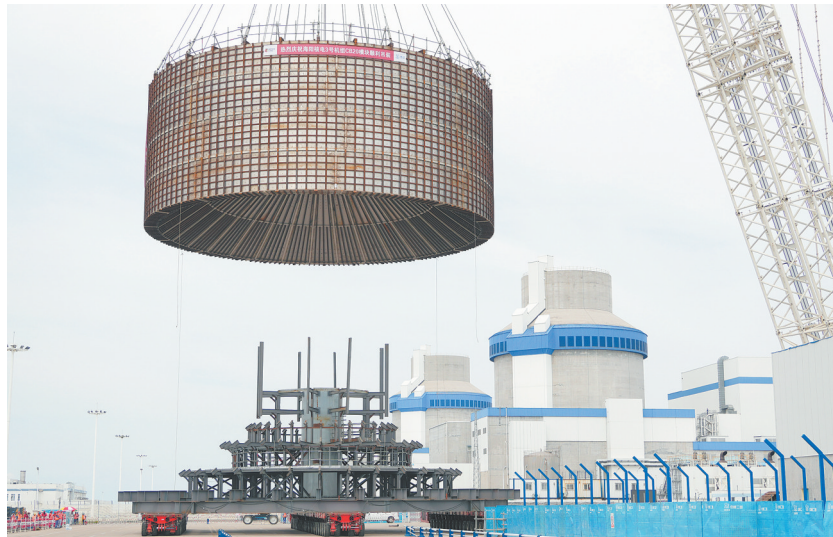
8月4日,国家电投山东海阳核电3号机组核岛CB20模块顺利吊装就位,标志着该机组大型模块全部吊装完成,开始进入设备安装调试阶段。图为当日拍摄的山东海阳核电3号机组核岛CB20模块吊装现场。
