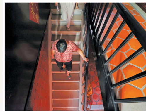
楼梯是用碗坯捶碎了加混凝土做成的，当年纯手工打造的楼梯，搭配木扶手，现在看起来还很实用。
