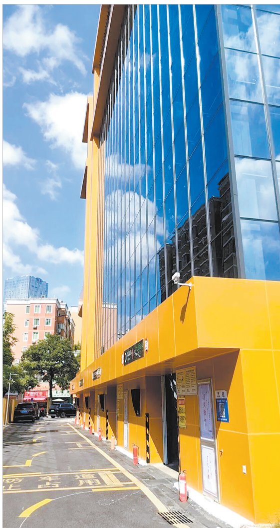
丰泽区祥远路立体停车场共有252个智能车位
