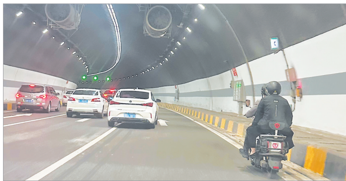
电动车在五台尾隧道内行驶
