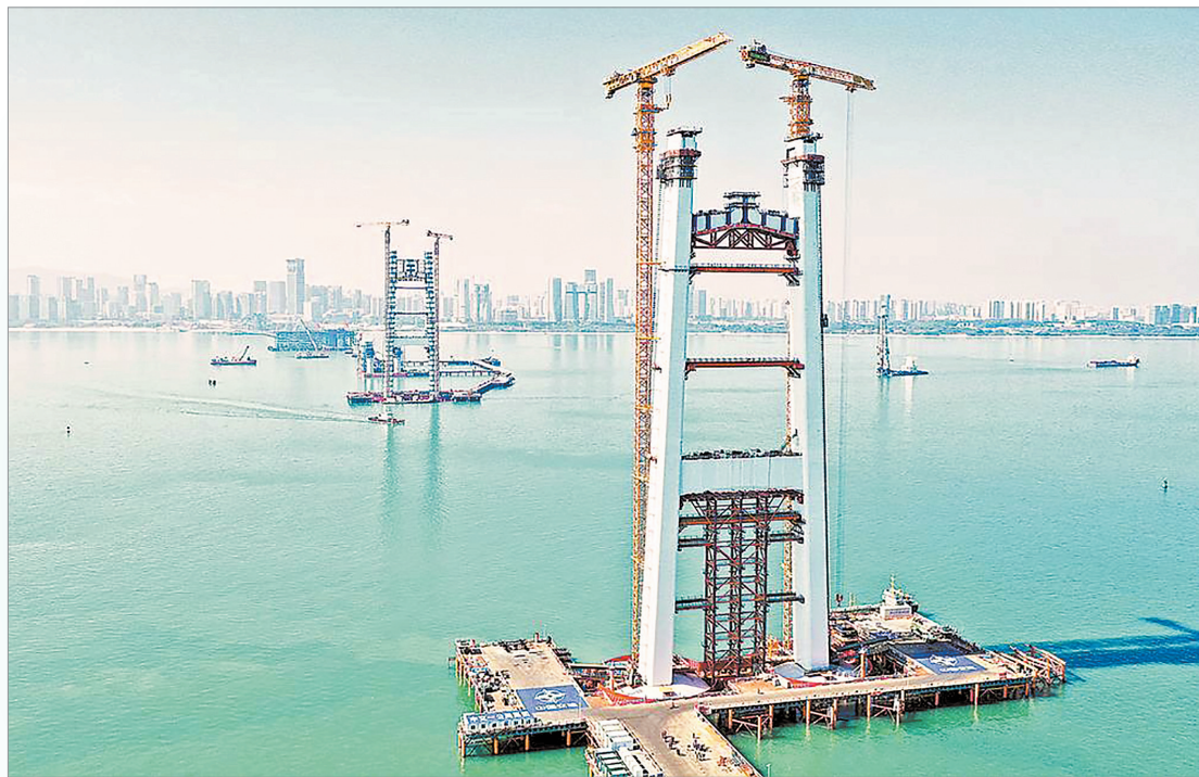
厦金大桥厦门段刘五店航道桥主塔顺利封顶
