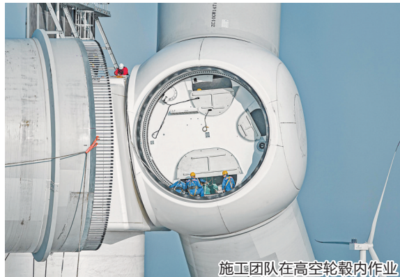
施工团队在高空轮毂内作业
