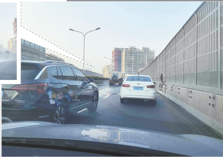
早高峰时段的坪山路高架桥上,正在作业的洒水车缓慢前行,导致道路拥堵。 (读者供图)
