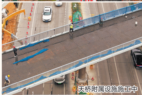
工人正在抓紧作业
