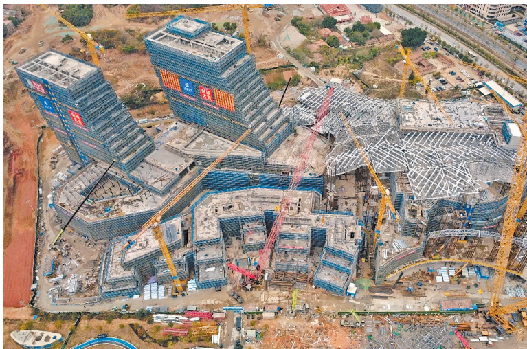
“海丝号”综合体项目实现主体封顶
