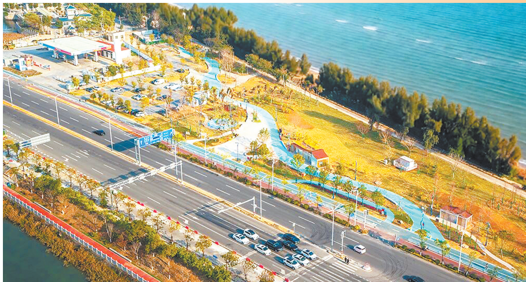
浔美湾沿岸景观提升项目通海段俯瞰图
