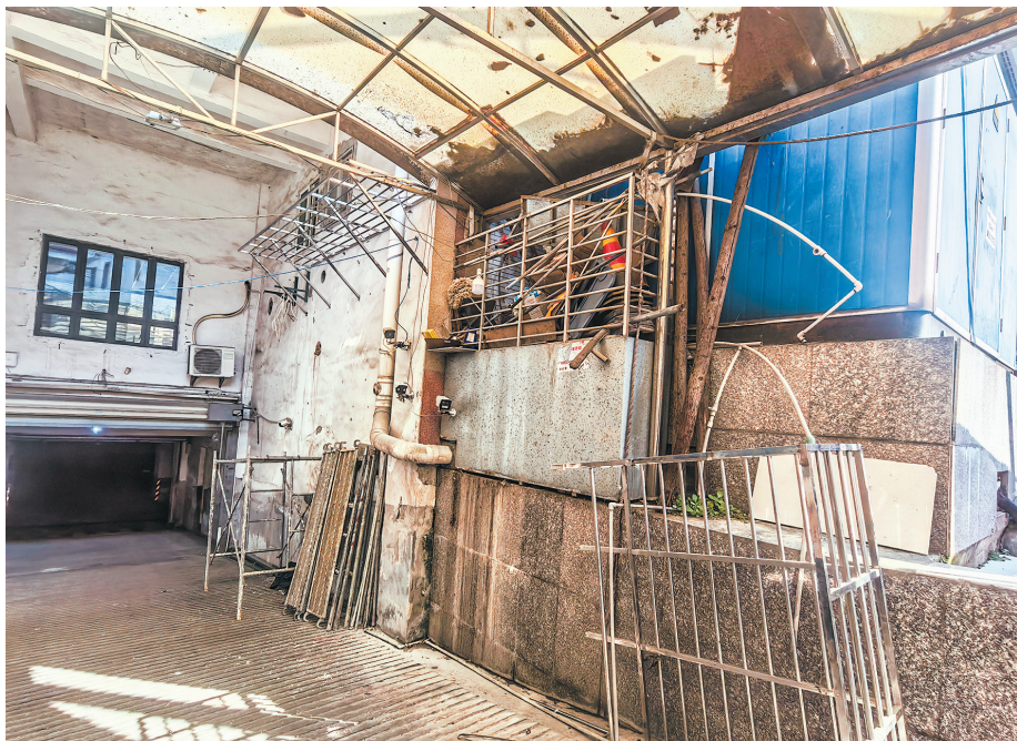
墙体被凿开两扇窗,还搭建不锈钢架。
