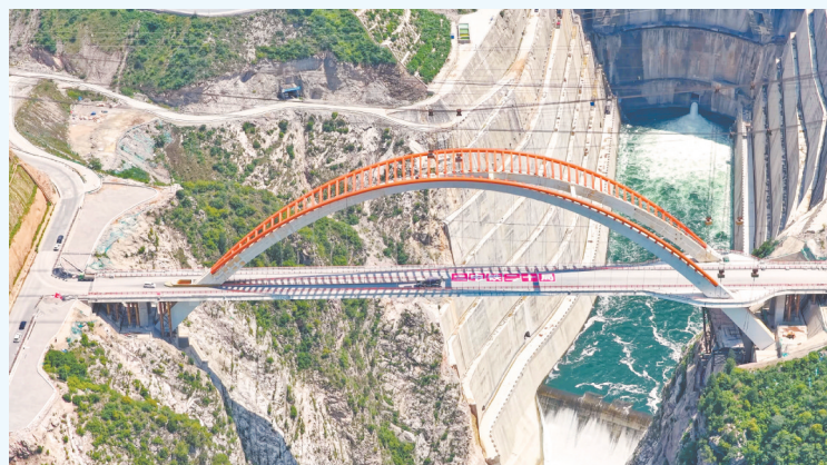
5月21日,由中铁二十局承建的陕西东庄水利枢纽泾河大桥完工。泾河大桥全长284米,是国内首例中承式空间Y型钢箱拱桥。图为21日拍摄的陕西东庄水利枢纽泾河大桥(无人机照片)。
