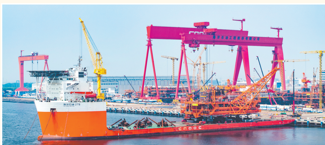
6月16日,随着最后一座平台在天津市滨海新区成功装船,全球最大变质岩油田——渤中26-6油田开发项目(二期)全部平台陆地建造完工,为油田按期投产奠定基础。
