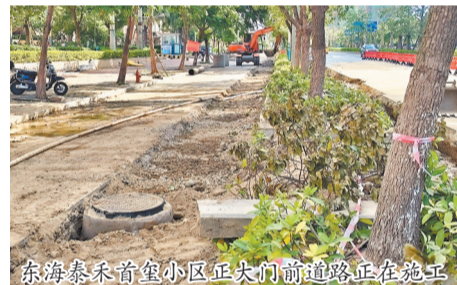
东海泰禾首玺小区正大门前道路正在施工
