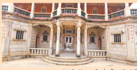
振成楼一层外廊“塌响”
