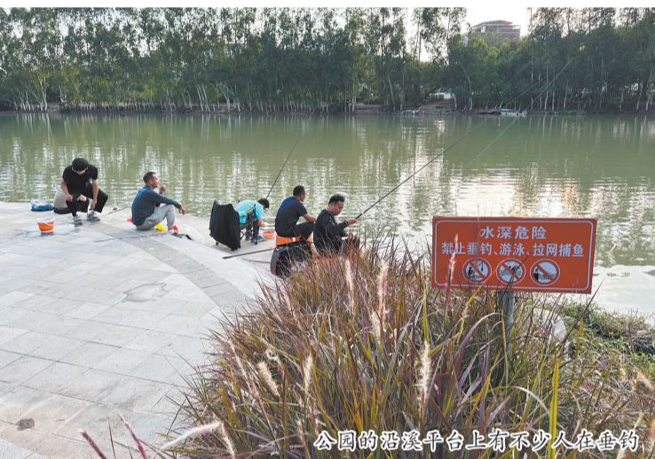
公园的木栈道破损严重
