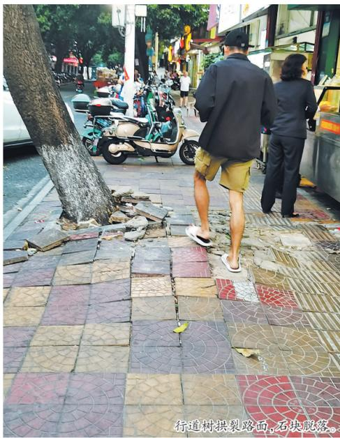
行道树拱裂路面,石块脱落。
