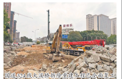
国道324线安溪桥拆除重建工程已全面复工
