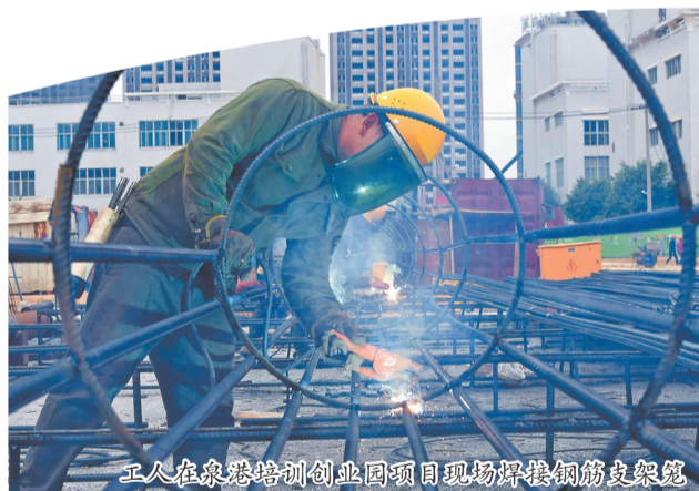
工人在泉港培训创业园项目现场焊接钢筋架梁
