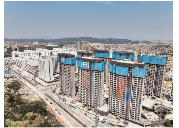
国投·狮城领秀项目8栋住宅楼全部完成主体封顶
