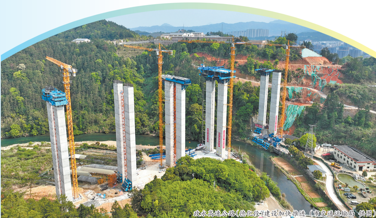
政永高速公路(德化段)建设加快推进。(市交通运输局 供图)
