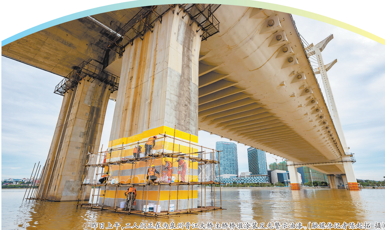
昨日上午，工人们正在为泉州晋江大桥主桥桥墩涂装反光警示油漆。（融媒体记者陈起超 摄）
