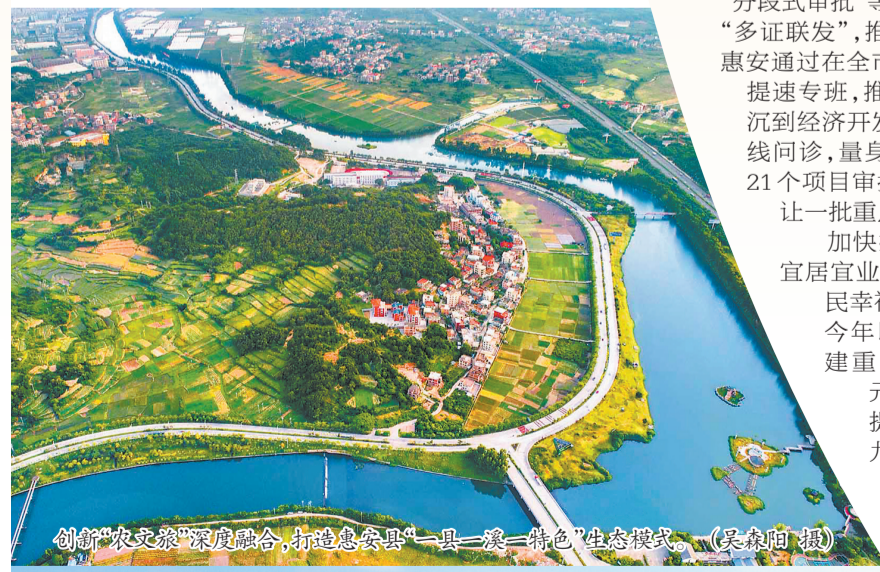
惠泉片区改造建设工程项目(许盼盼 姚文轩 摄)
