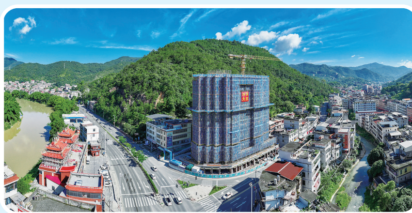
安溪县魁斗镇魁星大厦项目是市级重点项目,于2023年8月开工建设,预计总投资3500万元,主要建设总高度不超过80米楼房2栋,用于国道355线、省道312线魁斗交叉路口公路拓宽改造工程拆迁安置。目前,该项目主体工程已经封顶,正在进行内外装修及附属工程建设。(黄东华 摄)
