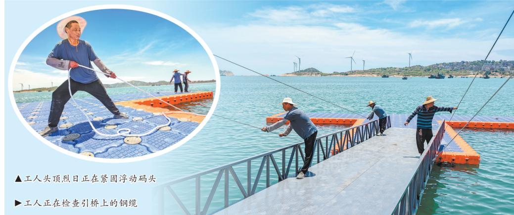
▲工人头顶烈日正在紧固浮动码头 ▲工人正在检查引桥上的钢缆
