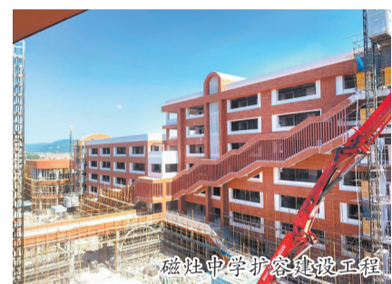
磁灶中学扩容建设工程
