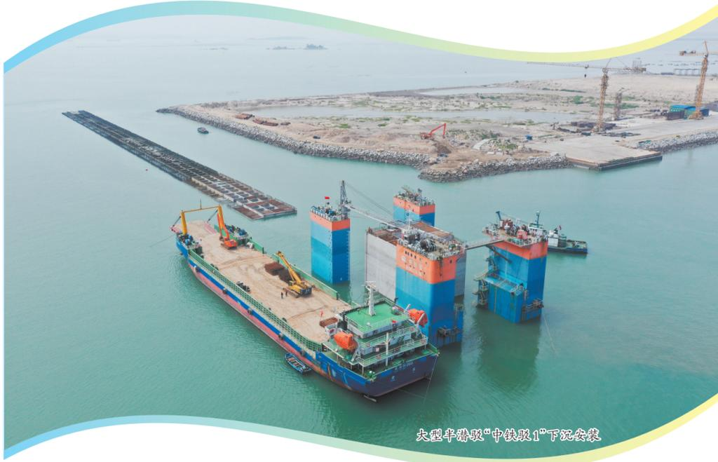
大型半潜驳“中铁驳1”下沉安装
