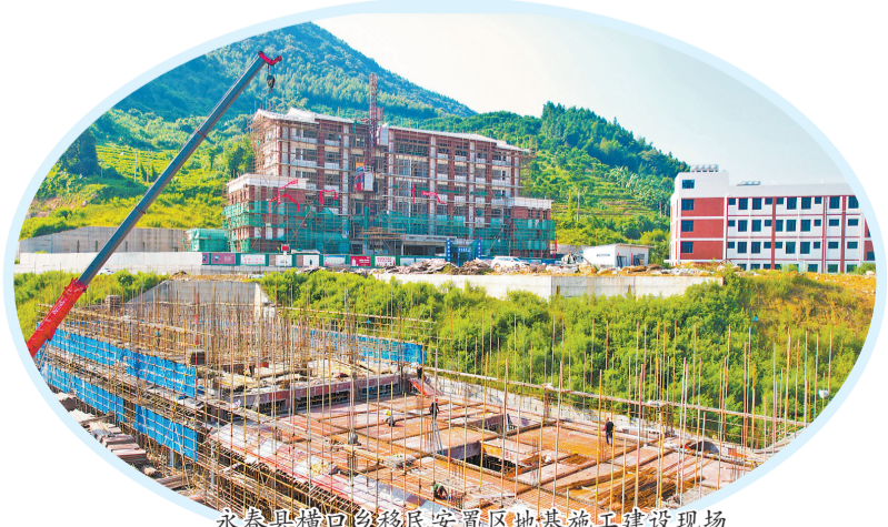
永春县横口乡移民安置区地基施工建设现场
