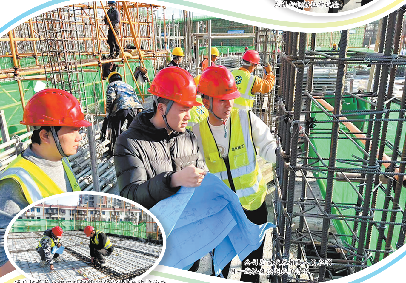
项目栋号长正组织对钢筋安装情况进行内控检查
