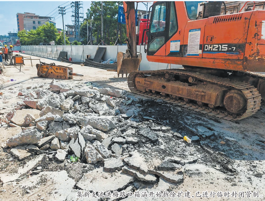
集新支流洪梅路回箱涵开始拆除扩建，已进行临时封闭管制。
