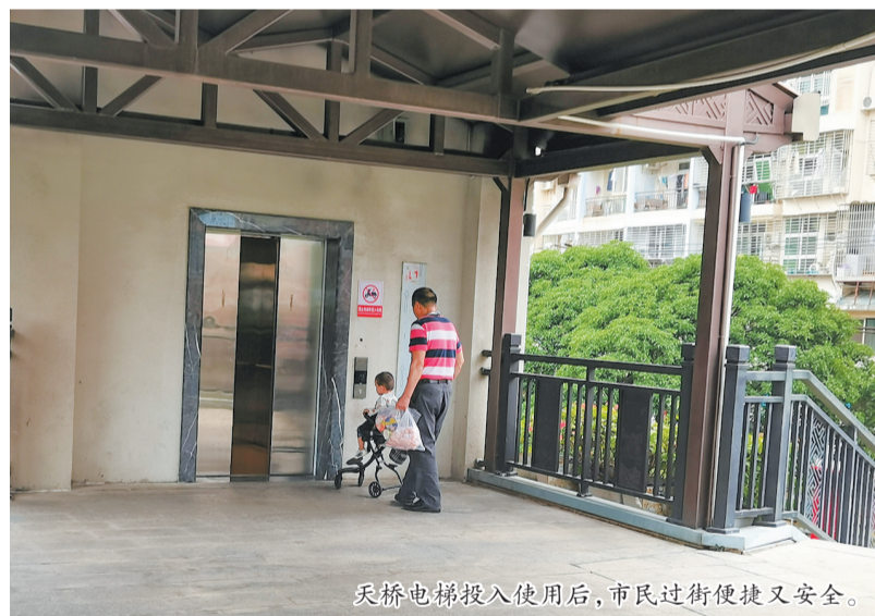
天桥电梯投入使用后,市民过街便捷又安全。
