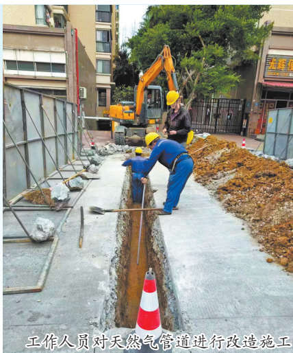
工作人员对天然气管道进行改造施工
