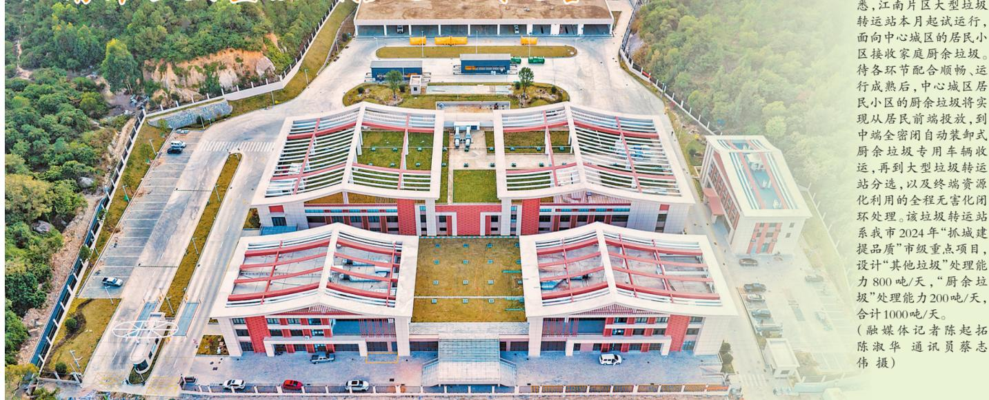
记者从城管局获悉,江南片区大型垃圾转运站本月起试运行,面向中心城区的居民小区接收家庭厨余垃圾。待各环节配合顺畅、运行成熟后,中心城区居民小区的厨余垃圾将实现从居民前端投放,到末端全密闭自动装卸式厨余垃圾专用车辆收运,再到大型垃圾转运站分选,以及终端资源化利用的全程无害化闭环处理。该垃圾转运站系我市2024年“抓城建提品质”市级重点项目,设计“其他垃圾”处理能力800吨/天,“厨余垃圾”处理能力200吨/天,合计1000吨/天。(融媒体记者陈起拓 陈淑华 通讯员蔡志伟 摄)
