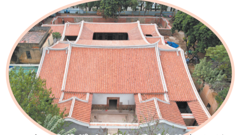
施琅故宅修缮后的俯视图(受访者供图)
