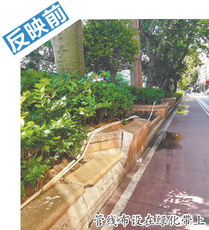
管线布设在绿化带上
