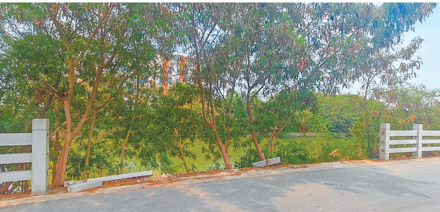
溪道护栏严重破损 (李先生 供图)
