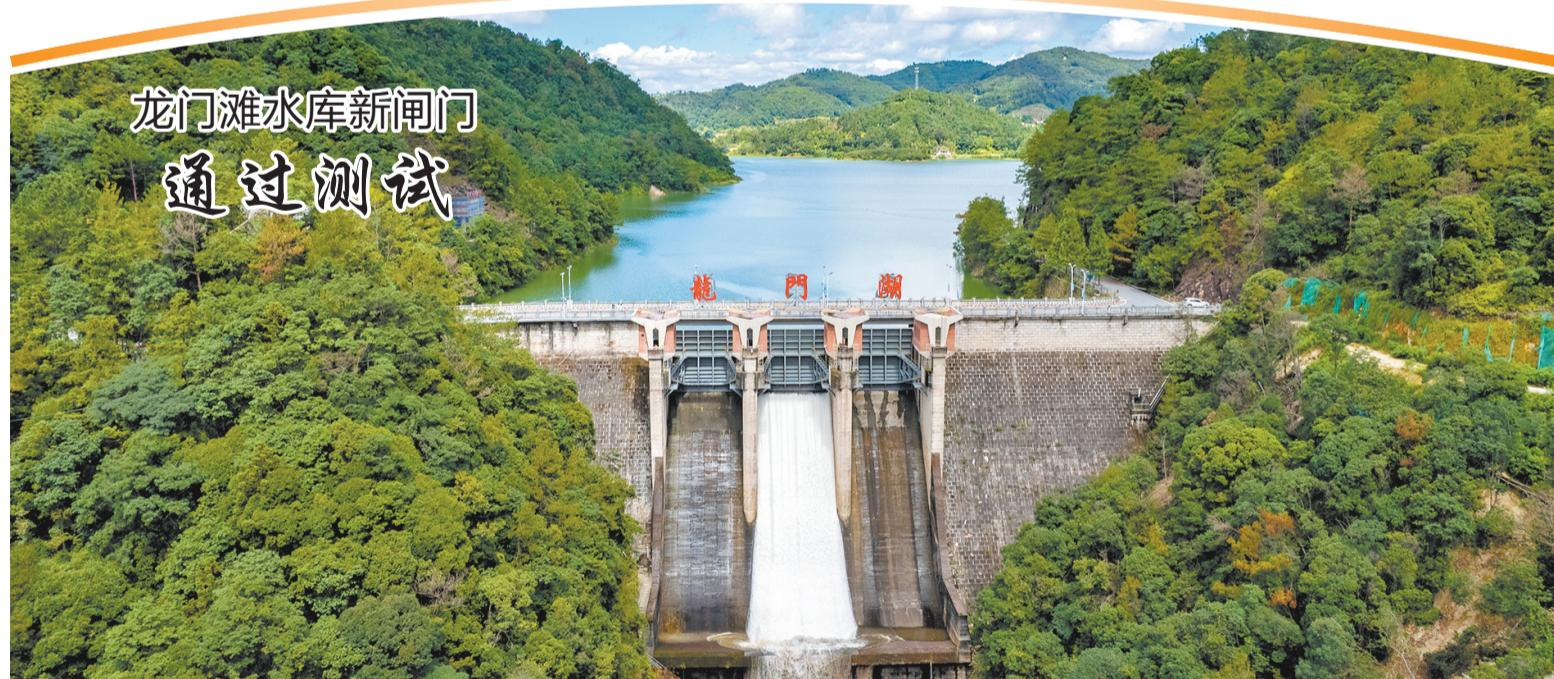
为保障水库长期安全运行,龙门滩水库管理单位于2024年8月启动溢洪道闸门应急除险工程。今年7月24日,管理单位对新闻闸实施动水启闭试验——即在水流冲击状态下进行开关测试。此次应急除险工程收官与关键试验成功,显著提升了龙门滩水库应对汛期洪水的能力。
