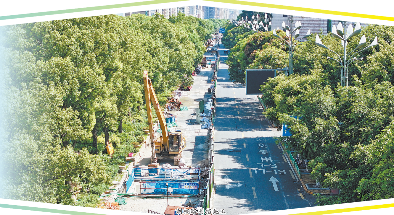
刺桐路围挡施工
