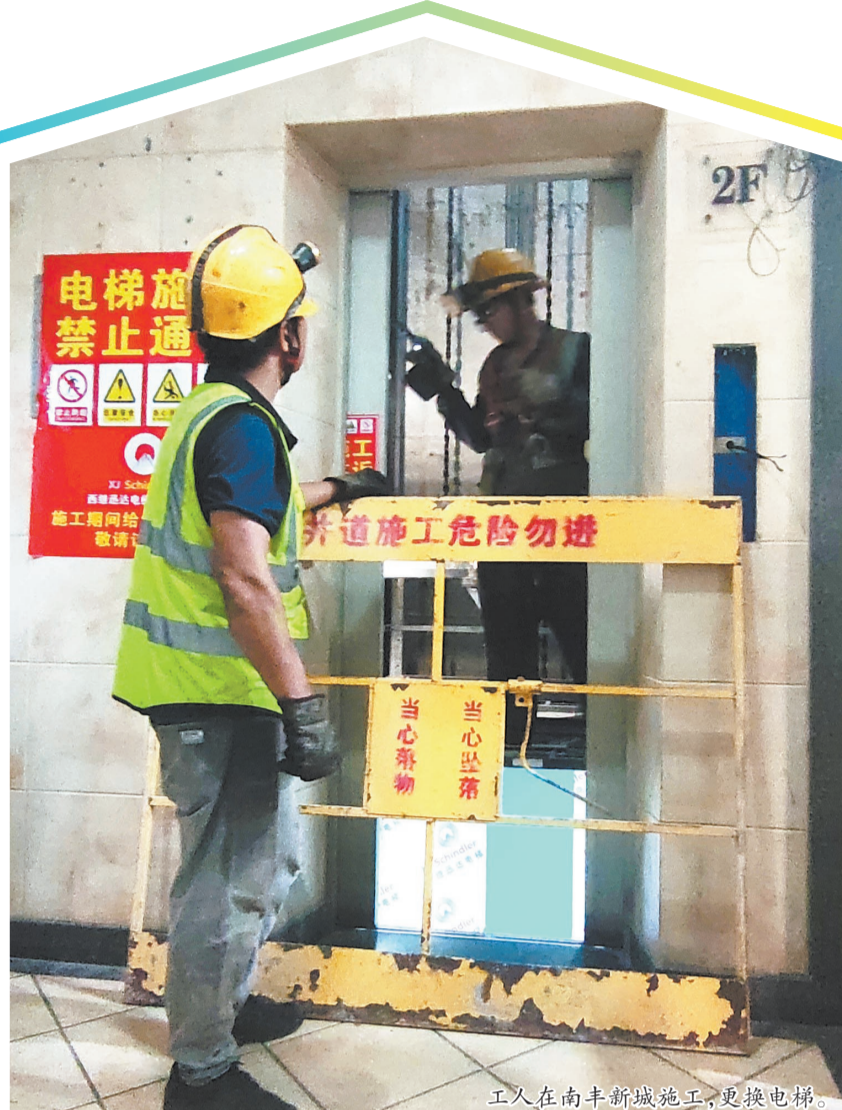
工人在南丰新城施工,更换电梯。
