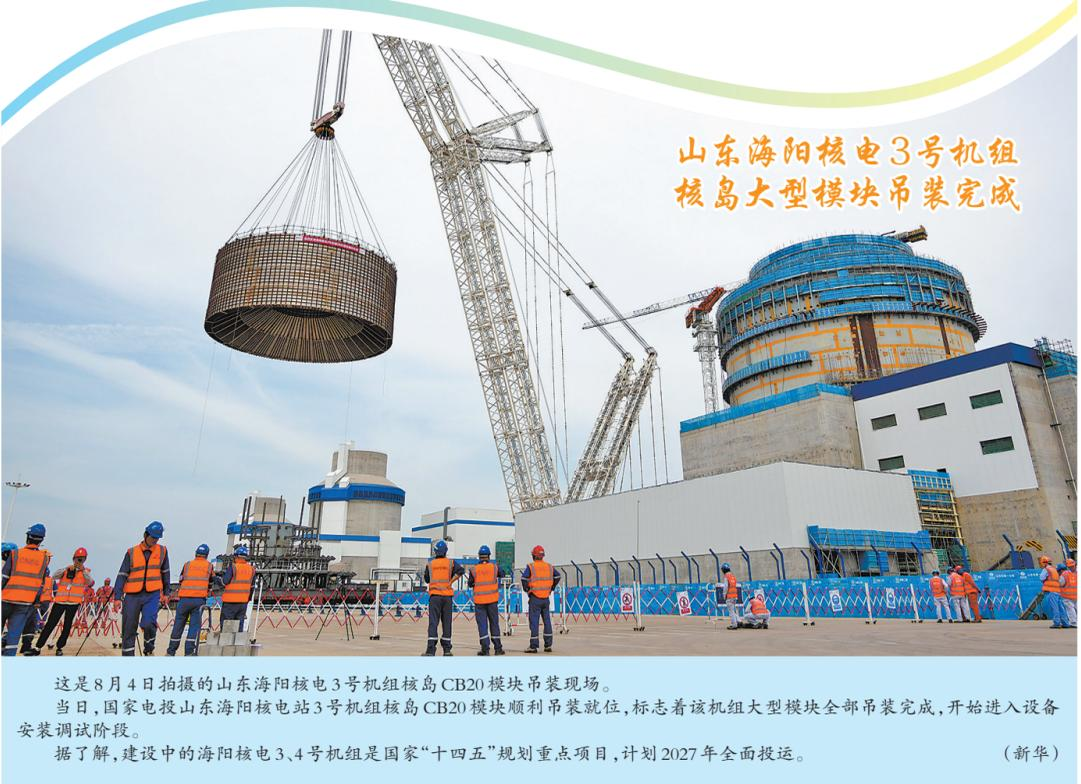
这是8月4日拍摄的山东海阳核电3号机组核岛CB20模块吊装现场。当日,国家电投山东海阳核电站3号机组核岛CB20模块顺利吊装就位,标志着该机组大型模块全部吊装完成,开始进入设备安装调试阶段。据了解,建设中的海阳核电3、4号机组是国家“十四五”规划重点项目,计划2027年全面投运。(新华)
