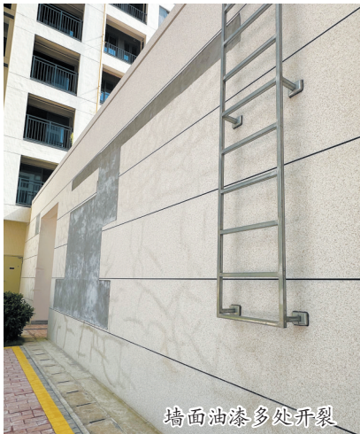
墙面油漆多处开裂
