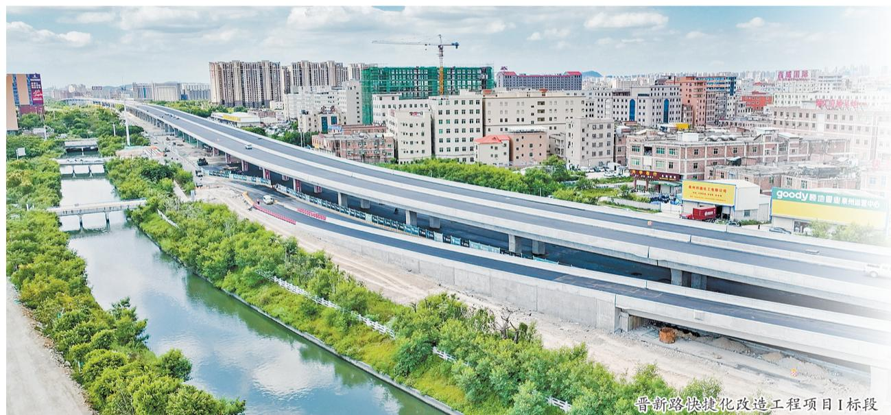
晋新路快捷化改造工程路线起于六源路(北接泉州晋江大桥),终于西滨镇军垦农场,全长约为8.74千米,路基宽度60米,按照一级公路兼城市快速路标准进行提升改造,设计速度80千米/小时。工程总投资21.75亿元,共三个标段,工期30个月。项目主要结构物:六源路至河滨北路段采取连续高架桥(桥长约3024米,设置一对上下匝道);河滨北路以南采取地面快速路+路口跨线桥形式,鹏青路跨线桥(桥长约479米),南港路跨线桥(桥长626米);东部快速路交叉口采取Y型枢纽互通;全线新建人行天桥3座。
