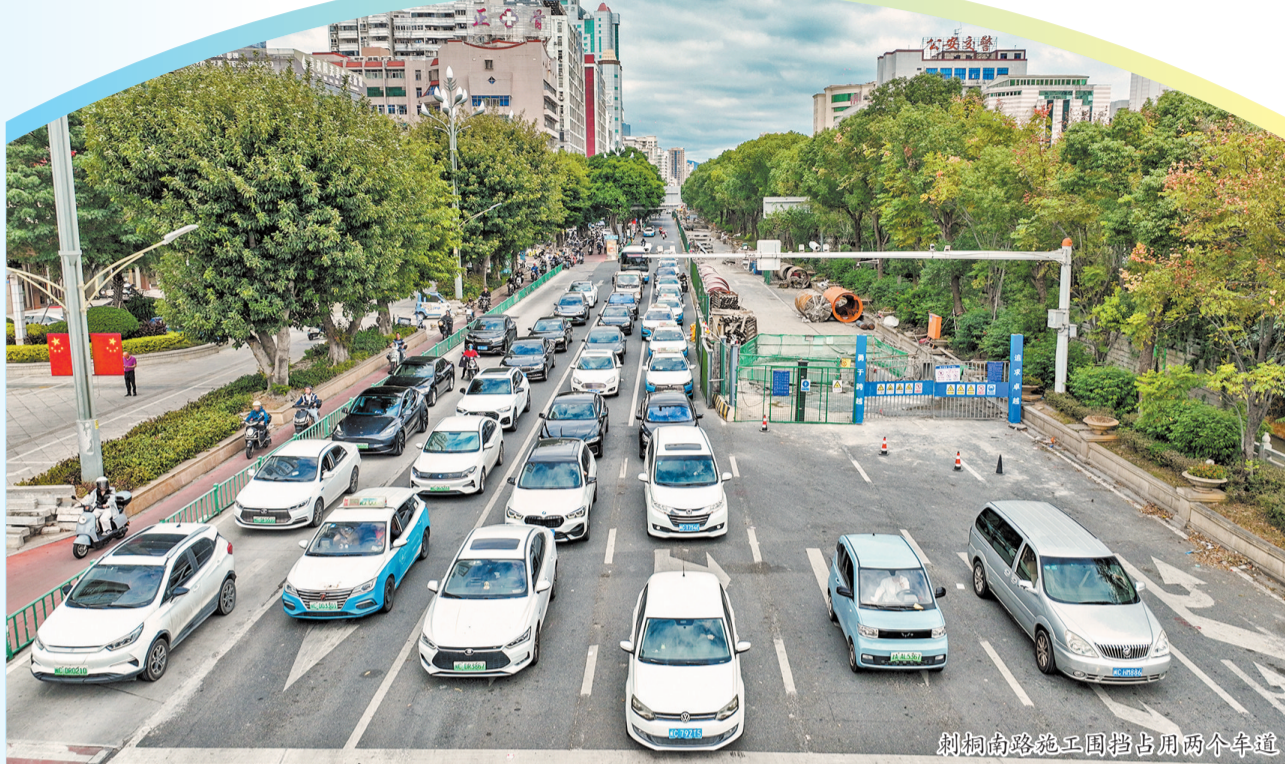
刺桐南路施工围挡占用两个车道
