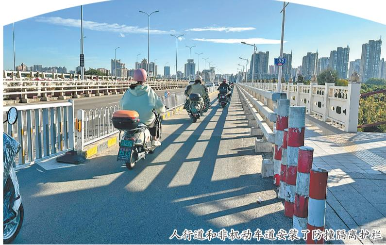
了防撞隔离护栏。大桥扩宽改造后,机动车道用护栏隔出一部分作为非机动车道。如此一来,原本的防撞隔离护栏就变成在人行道和非机动车道之间。如果将此防撞隔离护栏更换为简易护栏,起不到防撞作用。他提醒非机动车在通过该侧车道时要减速慢行,保持车辆间距,注意行驶安全。
