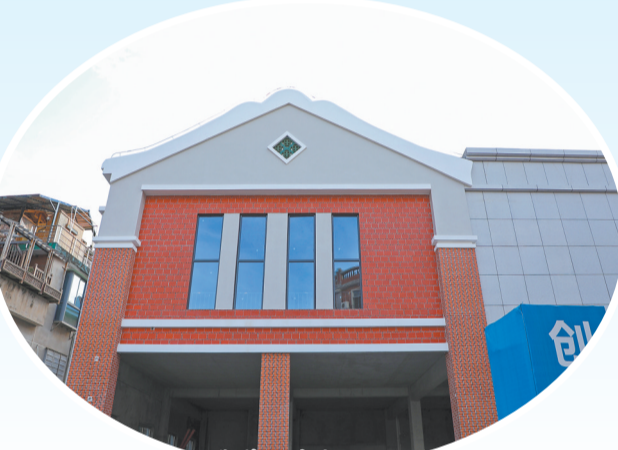
新门街莲灯巷南侧的站点已完成主体结构施工 (赖良德 摄)
