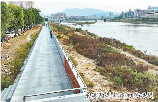
为减少对农田的占用,梅溪采用双层堤设计建造。
