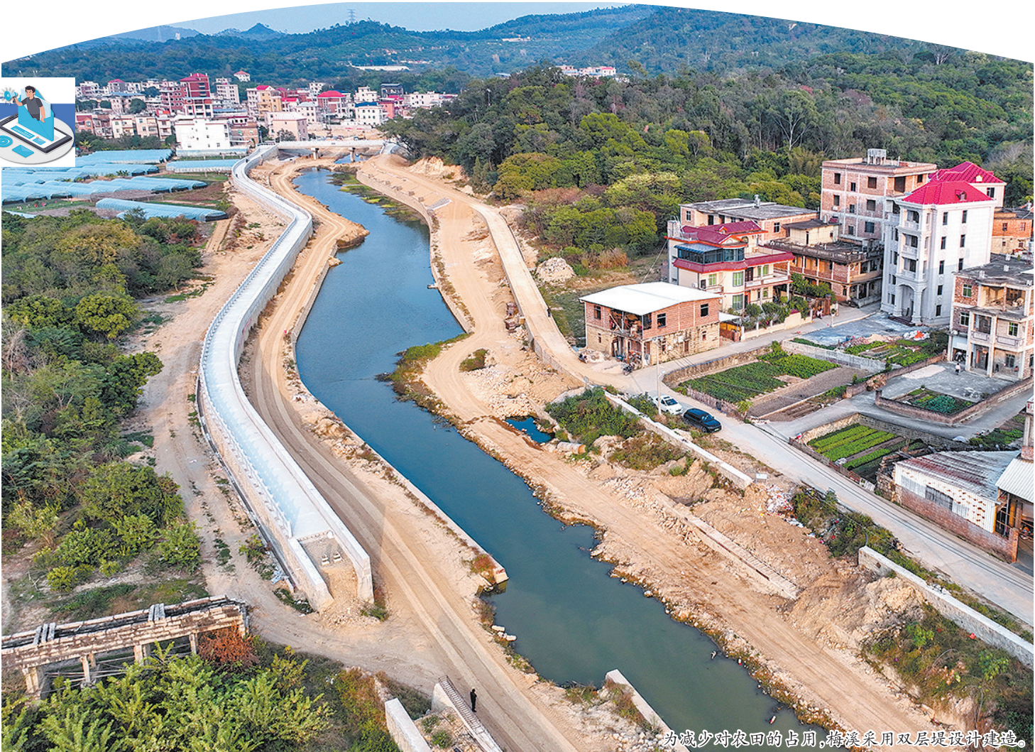
为减少对农田的占用,梅溪采用双层堤设计建造。
